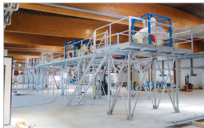
Čistota v průběhu montáže ve Finsku Foto JK Machinery
